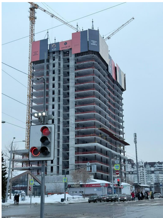
Рис. 4. Возведение 20-го этажа высотного здания
