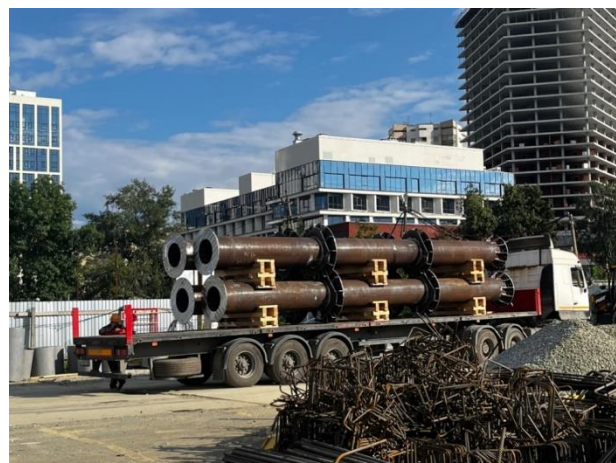
Рис. 3. Поставка готовых к монтажу стальных труб-оболочек Fig. 3. Delivery of ready-to-install steel casing tubes
