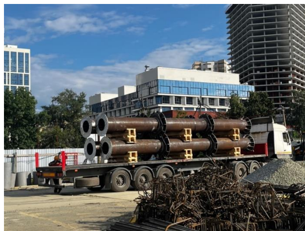
Рис. 3. Поставка готовых к монтажу стальных труб-оболочек Fig. 3. Delivery of ready-to-install steel casing tubes
