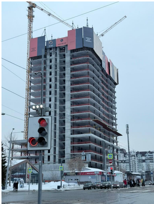
Рис. 4. Возведение 20-го этажа высотного здания
