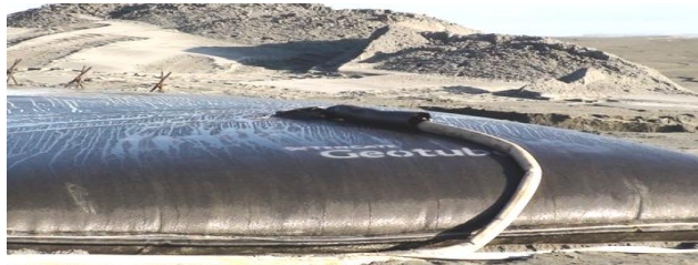
Рис. 1. Заполнение пульпой контейнера Geotub
